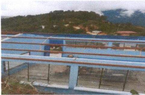
Foto 1: Mantenimiento y sustitución de lamina troquelada aluzinc calibre 26
