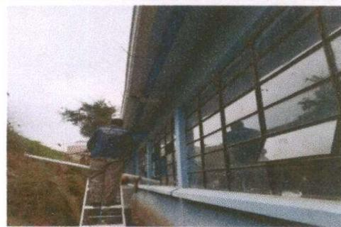
Foto 4: Instalación de bajadas de agua pluvial
